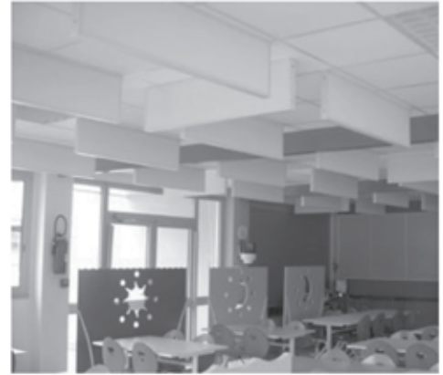
Salle de restauration après travaux
